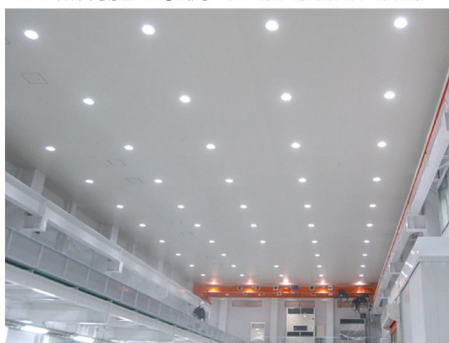
LED照明施工事例（工場、事務所、店舗）
