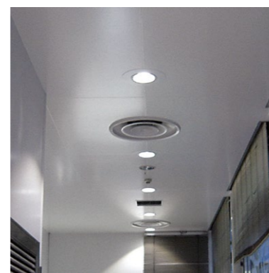
現状開口 φ 350 器具開口 φ 200 ダウンライト設置
