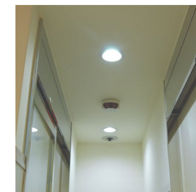
現状開口 φ 175 器具開口 φ 150 ダウンライト設置
